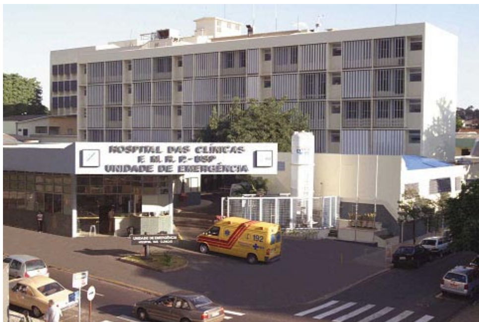
Figura 5 - Fachada da Unidade de Emergência (2002).
